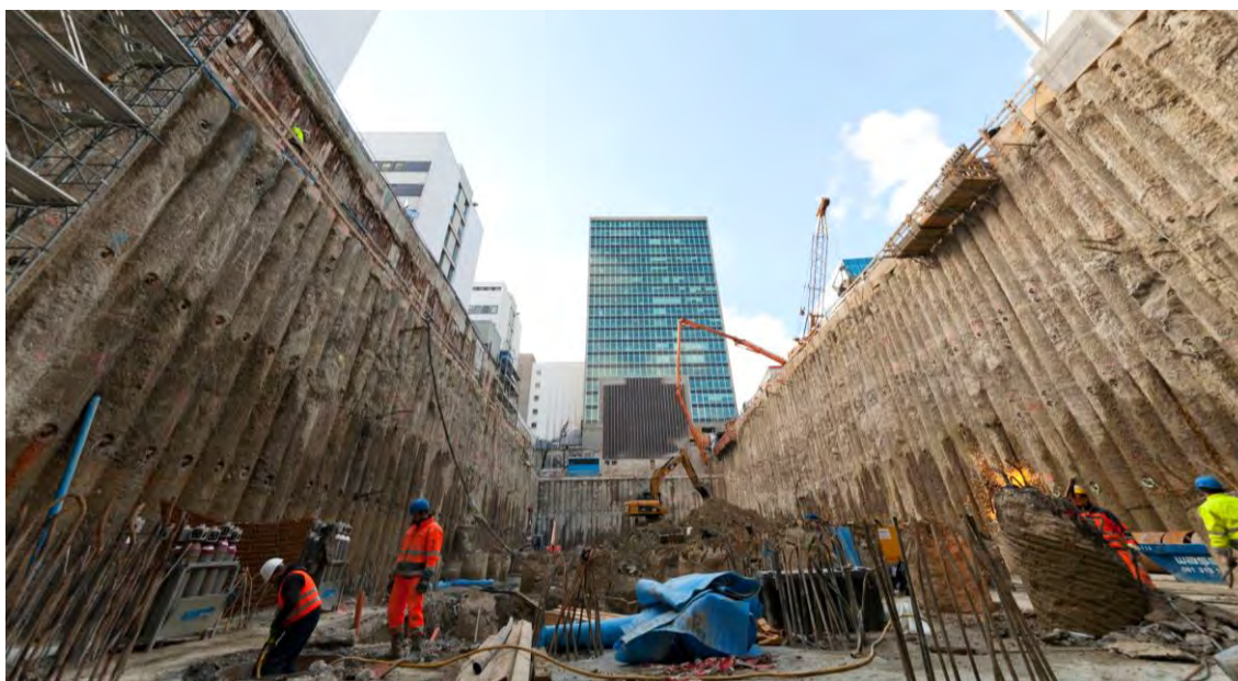
Bild 1 Endaushub der Baugrube für den Roche Bau 1 im Basler Wettsteinquartier. Im Hintergrund der 62 m hohe Bau 52 (Copyright: F. Hoffmann-La Roche AG, Basel)
