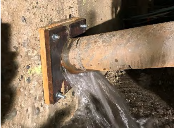
Abbildung 20: Abdichtung bei der Ankerbohrung mittels Quetschdichtung.
