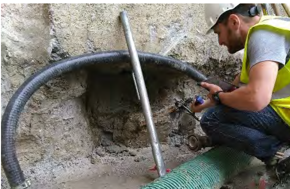
Abbildung 4: Teil des einbetonierten Schlitzwandgreifers der auf Höhe des Endaushubs freigelegt wurde.
