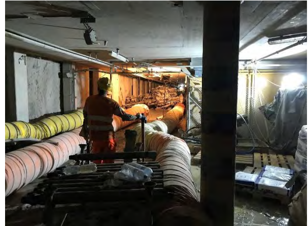
Abbildung 15: Extrem beengte Platzverhältnisse mit erschwelter Bewetterung
