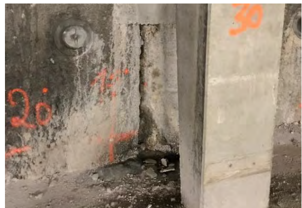
Abbildung 24: "Offene" Schlitzwandfuge.
