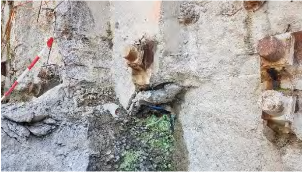
Abbildung 25: Sickerbeton unter einer alten Betonschürze auf Höhe der damaligen Gründungssohle.
