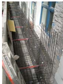
Fassadenverstärkung durch vorbetonierte Wandscheibe
