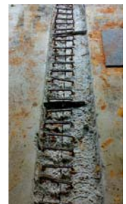
Schliessen der Dilationsfugen
